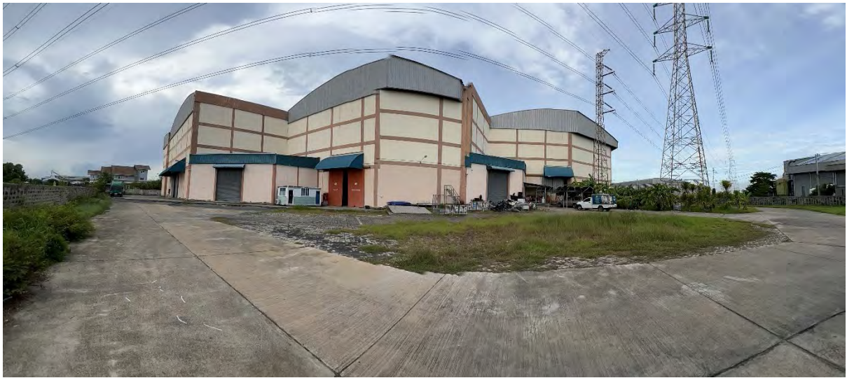
สภาพถนนภายในโครงการคลังเอกสารและคลังสินค้าผ่านหน้าคลังสินค้า 3
