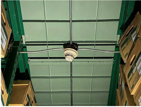
สภาพระบบตรวจจับควันไฟ และระบบไฟฟ้าส่องสว่างฉุกเฉิน
