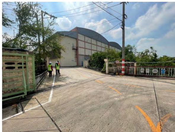
สภาพสะพานคอนกรีตเสริมเหล็กเป็นทางเชื่อมระหว่างคลังสินค้า 2 และคลังสินค้า 3
