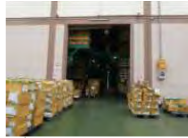
รายการที่ 8) อาคารคลังเอกสารหมายเลข 50
