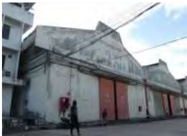
รายการที่ 1) อาคารคลังเอกสารหมายเลข 26
