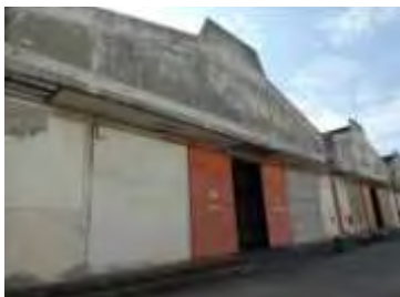
รายการที่ 3) อาคารคลังเอกสารหมายเลข 28
