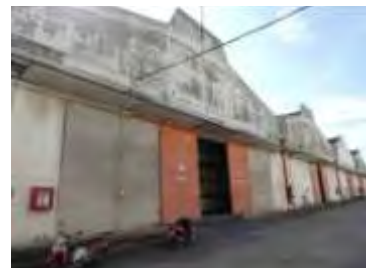
รายการที่ 4) อาคารคลังเอกสารหมายเลข 29
