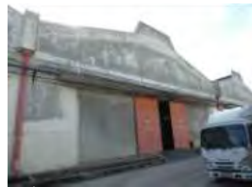
รายการที่ 2) อาคารคลังเอกสารหมายเลข 27
