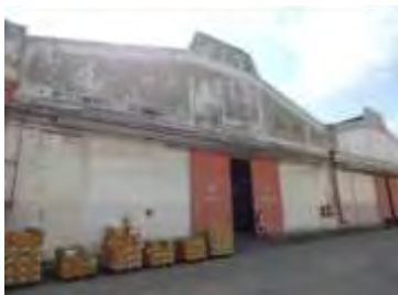
รายการที่ 5) อาคารคลังเอกสารหมายเลข 30
