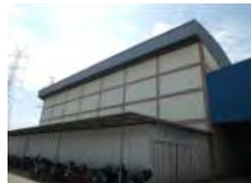
รายการที่ 6) อาคารคลังเอกสารหมายเลข 45
