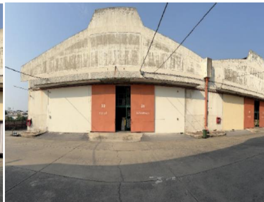
อาคารคลังหมายเลข 39
