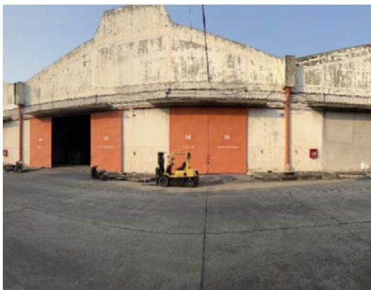
อาคารคลังหมายเลข 36
